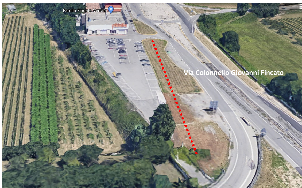
Figura 3-1 Vista del parcheggio supermercato Famila e area verde oggetto di intervento (linea rossa punteggiata).
