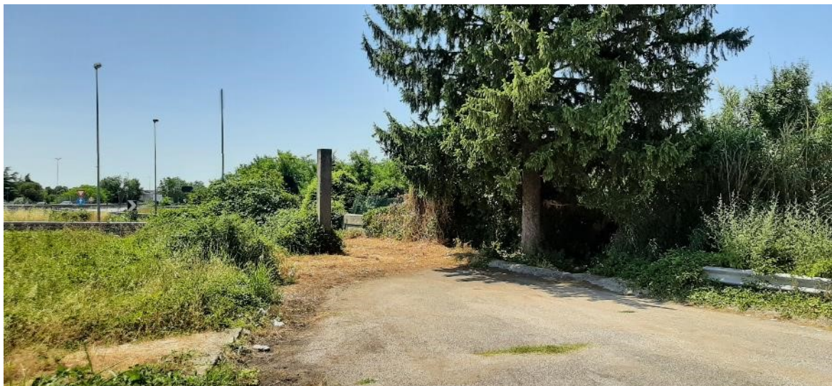
Figura 3-7 Ponte di scavalco del ex-Progno Valpantena
